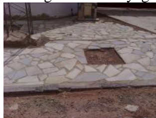
Trottoirs revêtus en marbre à Kasserine
